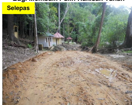
Gambar 1.10 Keadaan Kerja-kerja Menambak Tanah Bagi Membaik Pulih Hakisan Tanah
