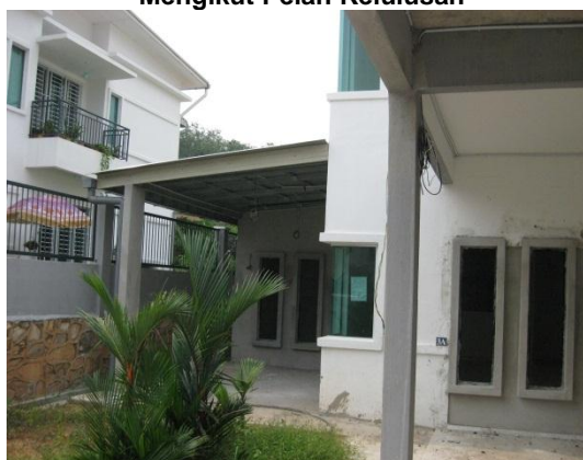
Gambar 2.9 Tambahan Bahagian Tepi Bangunan Tidak Mengikut Pelan Kelulusan
