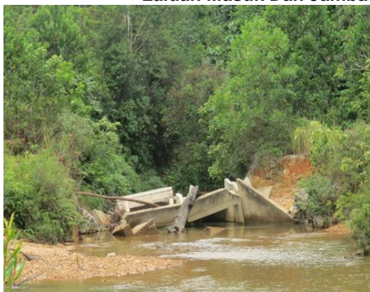
Gambar 1.19 Laluan Masuk Dan Jambatan Yang Runtuh Akibat Banjir
