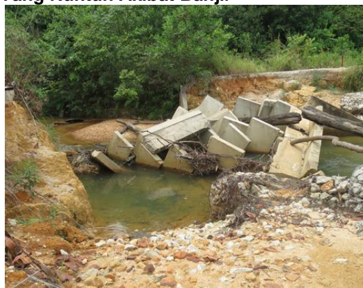
Gambar 1.19 Laluan Masuk Dan Jambatan Yang Runtuh Akibat Banjir
